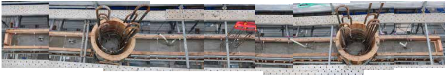
主柱・貫木部コンクリート打設完了状況
