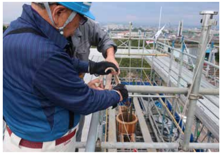
主柱のコンクリート打設は直高 5 m 直径 60 c m 打設中コンクリート内から空気を抜く方法として古くから伝わる工法 先を割いて竹内の節を除去した真竹を、打設中、上部からコンクリートに突き刺し空気を抜く
