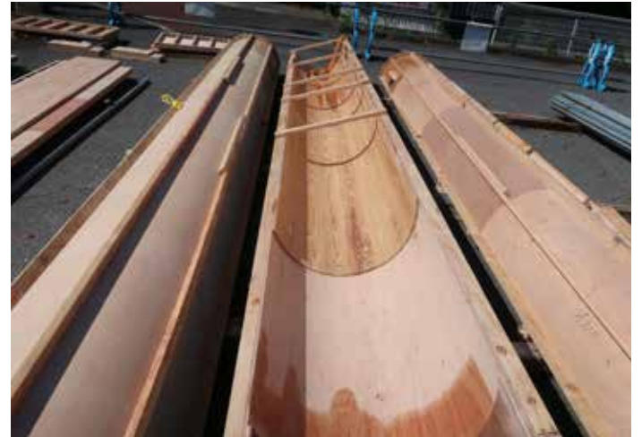
型枠剥離材塗布完了
