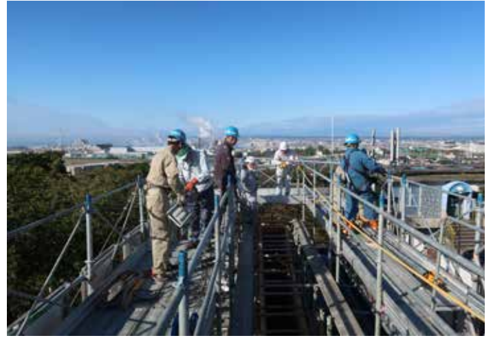
コンクリート打設前施工打ち合わせ
