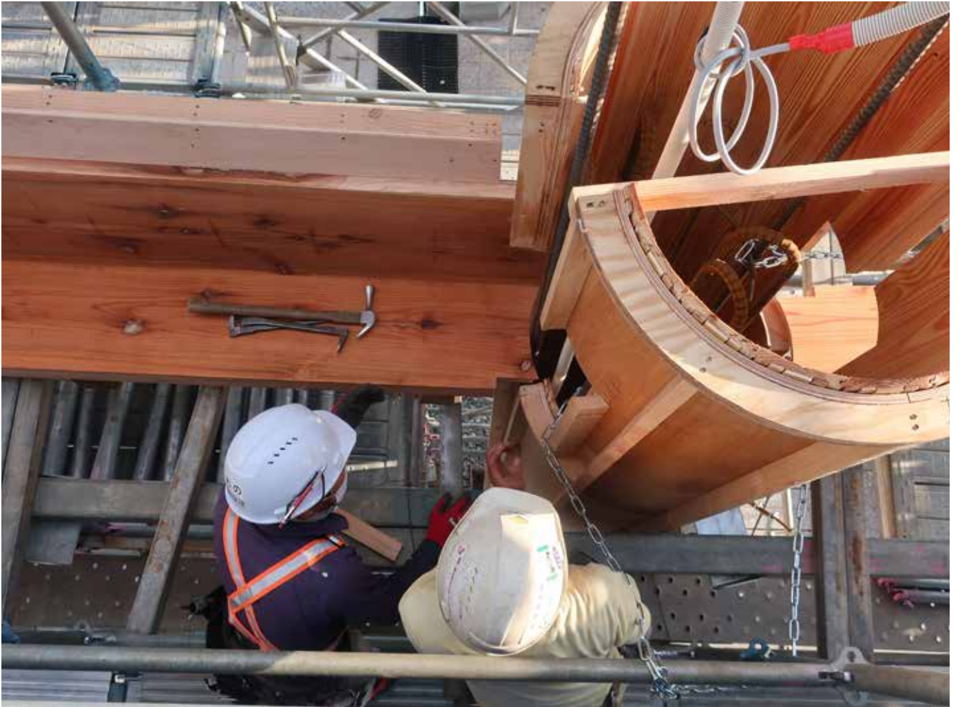
主柱貫木部型枠建込
