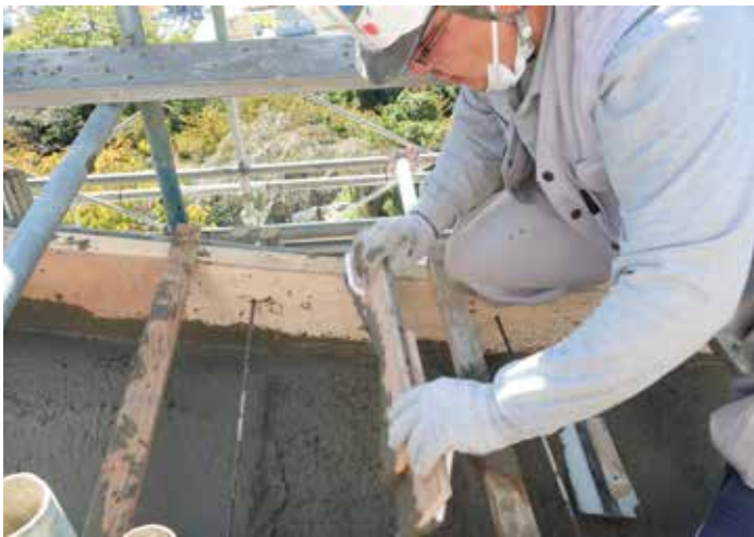
鳥居の最上部にあたる笠木は、中心から両端に向けて天を仰ぐように反り増しがあり、幅も両端に向けて太くなる形状。 笠木は山型形状であるため、仕上げ左官には熟練の技がいる。
