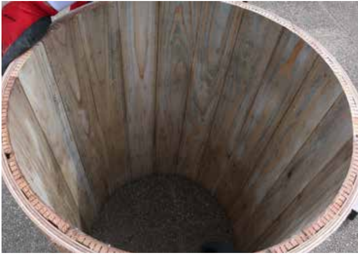
杉板本実型枠（浮造り加工済み）
