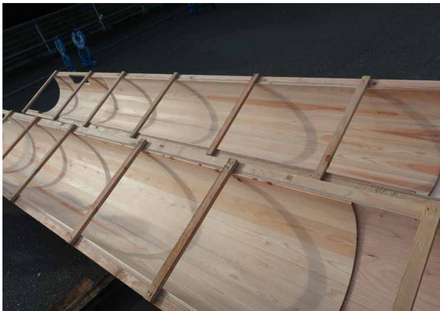
秋田杉を加工した型枠搬入
