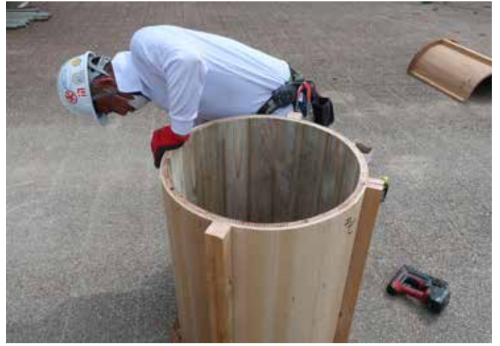
主柱基礎部の円形型枠組立
