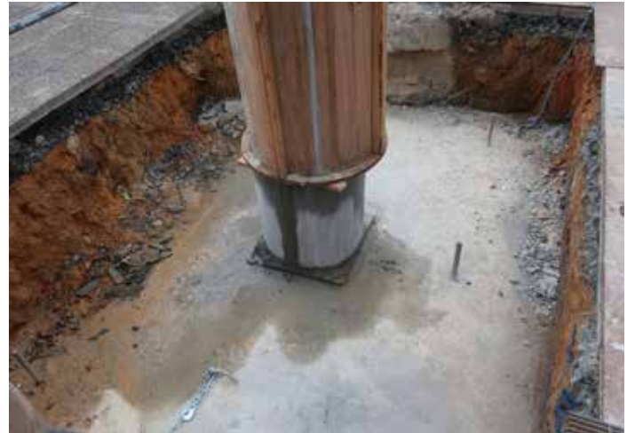
主柱基礎部：脱枠状況
