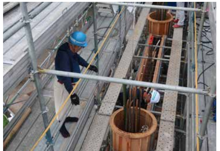
コンクリート打設前に支柱型枠の斜傾しないようにワイヤーの取り方を指導する遠藤会長
