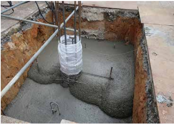
ベースコンクリート打設状況
