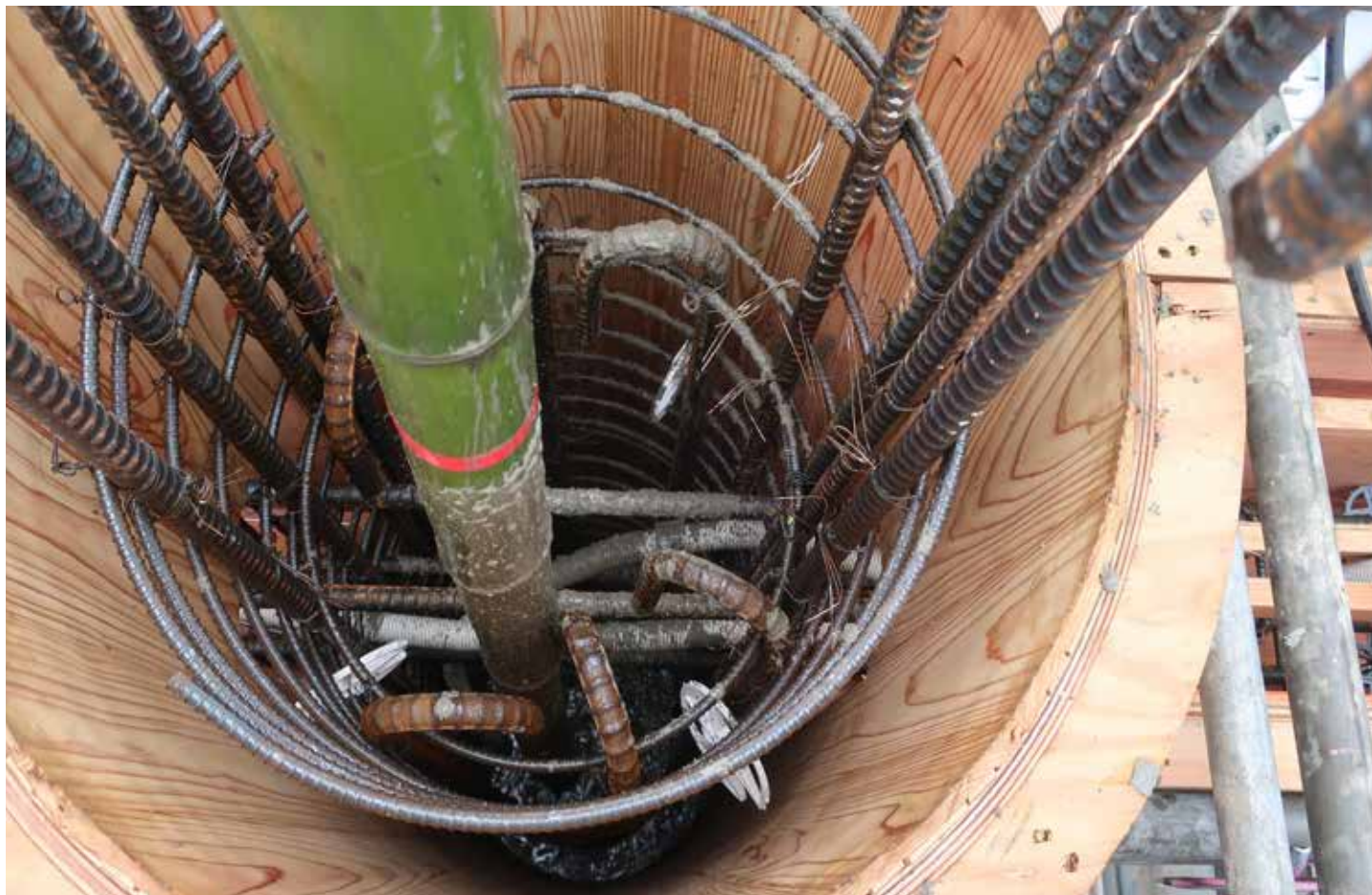
コンクリートは高さ 1.5 m 毎に 3 回に分け打設
