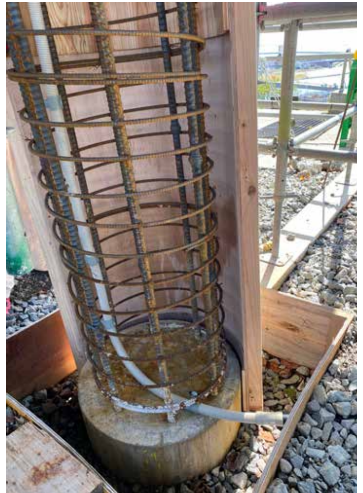
主柱型枠建込
