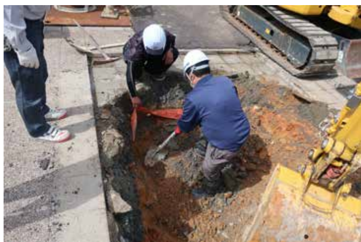
掘削（埋設電線管：街灯用電線）
