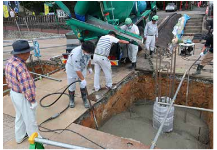
ベースコンクリート打設状況
