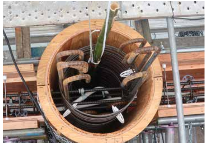
空気抜き竹をセットした状況
