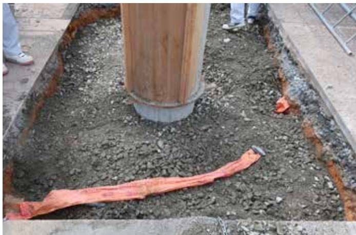
1層目締固め完了状況
