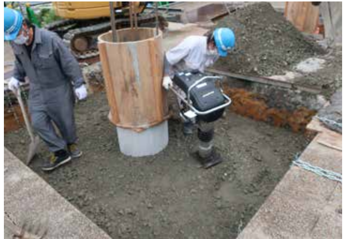
1層目締固め状況
