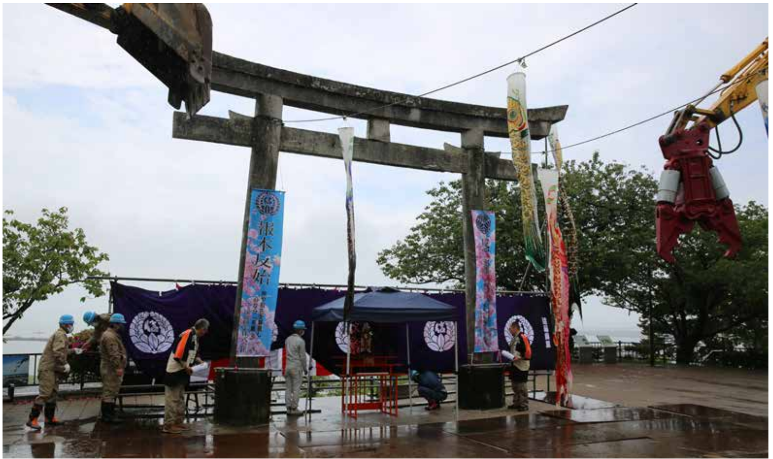
作業開始の前に千葉和幸土木部長と大平義彦土木部次長による清め祓いを行う。
