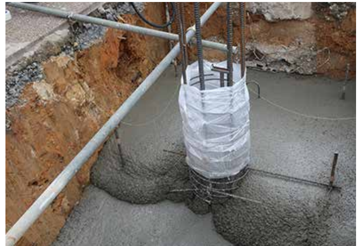
左主柱基礎部に奉鎮
