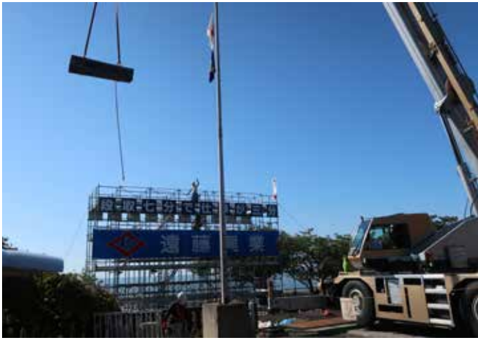
支保工材揚重
