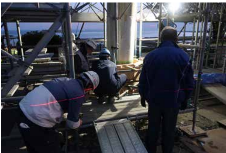
人力でコンクリート運搬・打設
