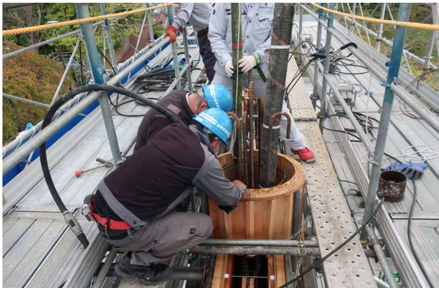
主柱部コンクリート打設開始
