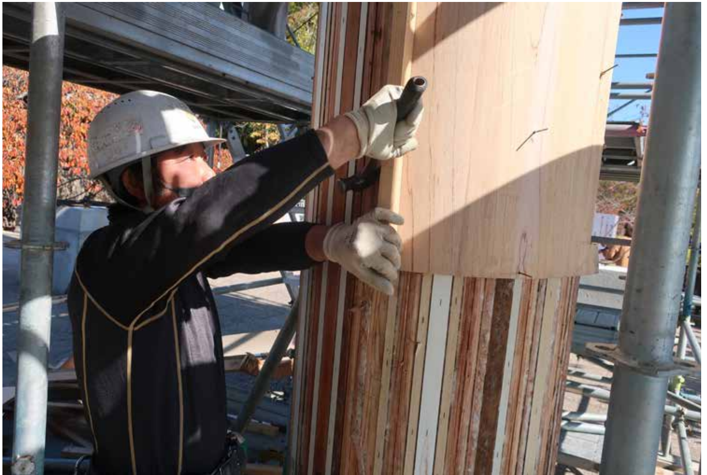
主柱の型枠解体、合板の内側に秋田杉を本実しているの順番に解体する
