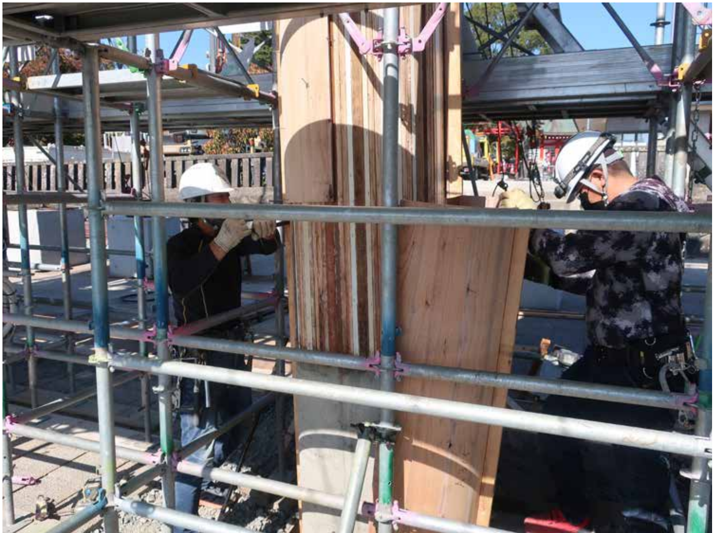
主柱の型枠解体、合板の内側に秋田杉を本実しているの順番に解体する
