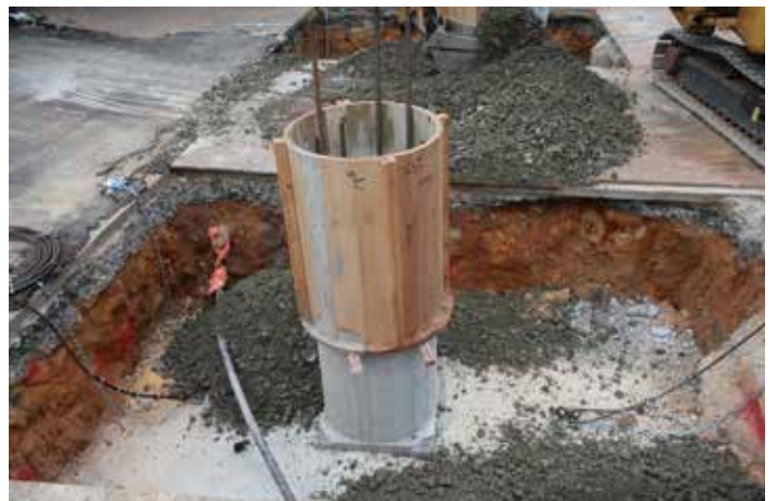
1層目締固め状況
