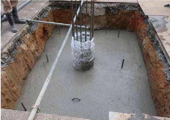
ベースコンクリート打設完了
