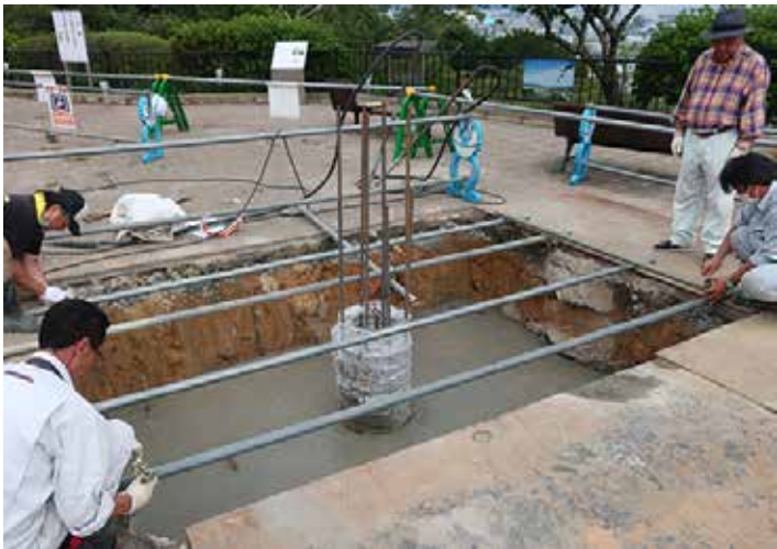
ベースコンクリート打設完了
