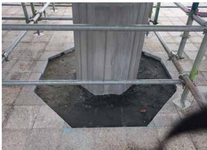
基礎周辺の平板ブロックを基礎形状と同じように八角形に仕上げる
