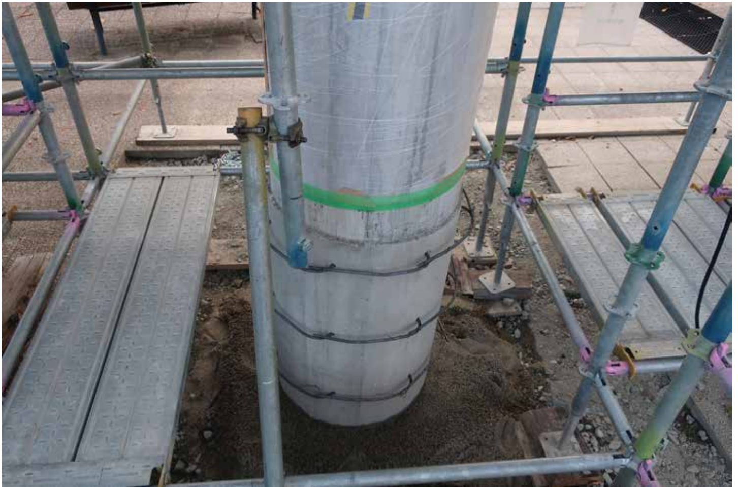
主柱の根元 亀腹部の根巻コンクリート
