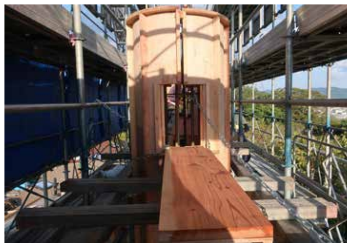
主柱貫木部型枠建込
