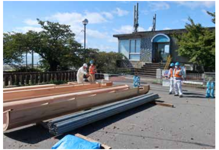
型枠剥離剤塗布
