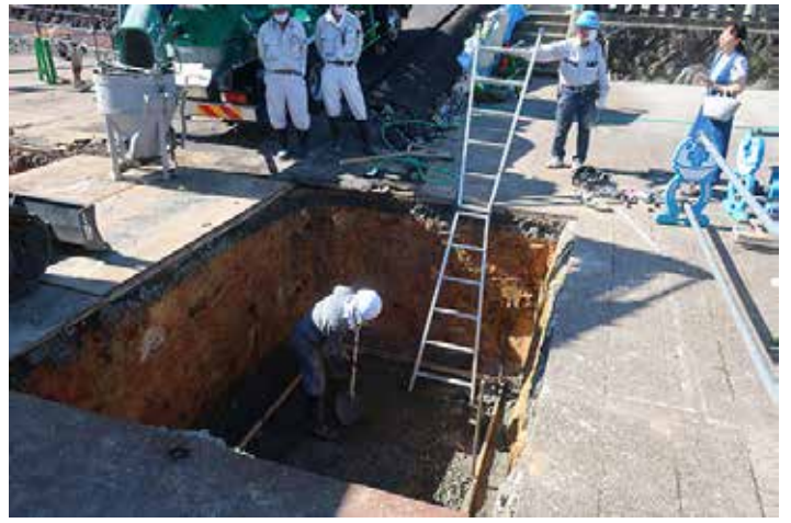
捨てコン打設状況
