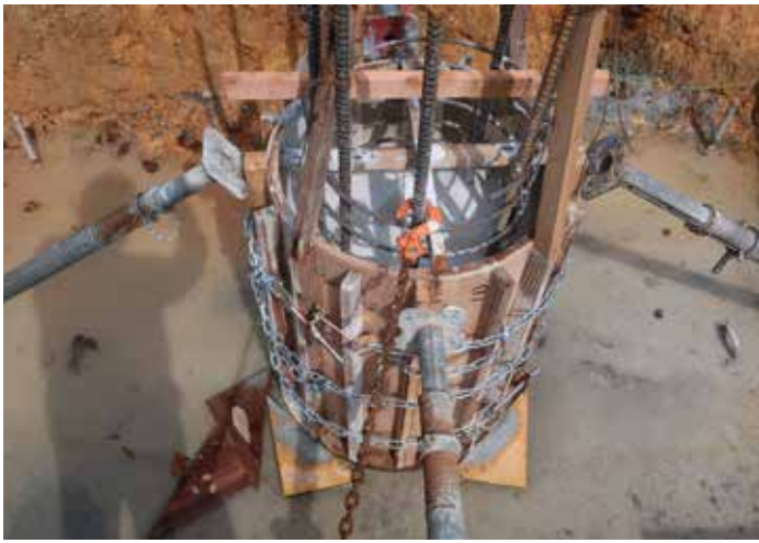
主柱基礎部コンクリート打設
