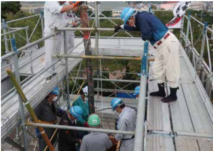
打設前にシミュレーション
