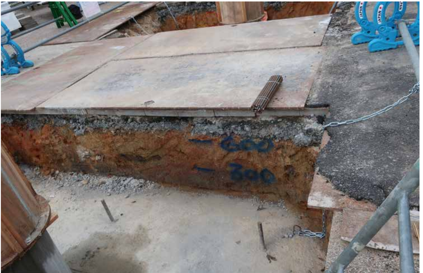
主柱基礎部：脱枠状況
