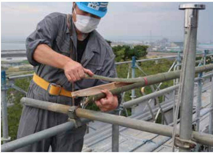
主柱のコンクリート打設は直高 5 m 直径 60 c m 打設中コンクリート内から空気を抜く方法として古くから伝わる工法 先を割いて竹内の節を除去した真竹を、打設中、上部からコンクリートに突き刺し空気を抜く
