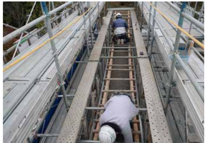
鳥居の最上部にあたる笠木は、中心から両端に向けて天を仰ぐように反り増しがあり、幅も両端に向けて太くなる形状。 笠木は山型形状であるため、仕上げ左官には熟練の技がいる。
