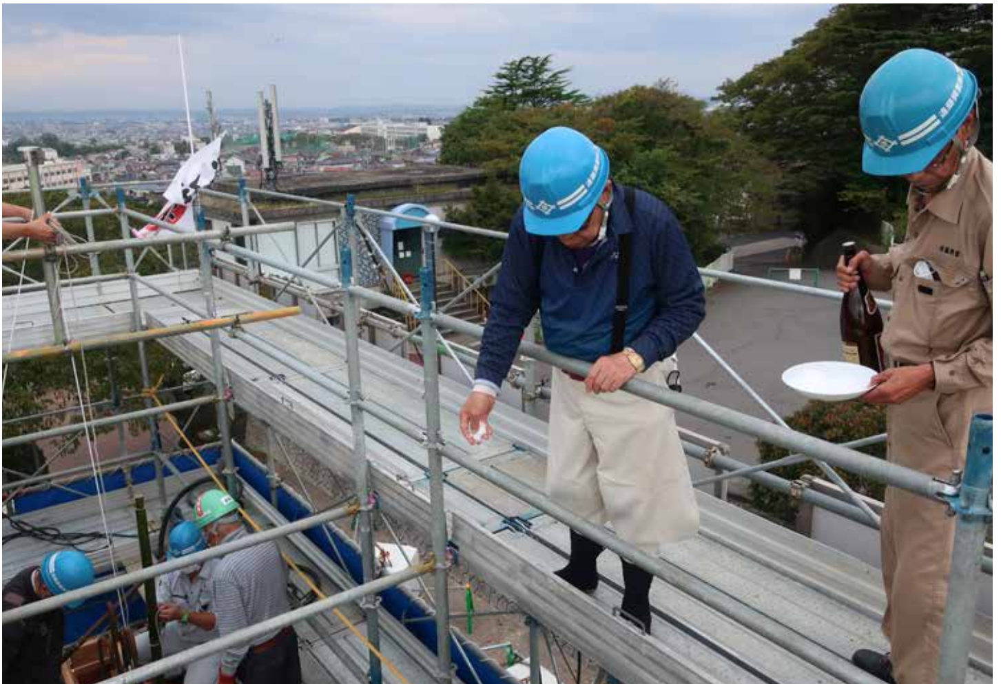
コンクリート打設開始前に安全祈願とお清めをする遠藤会長
