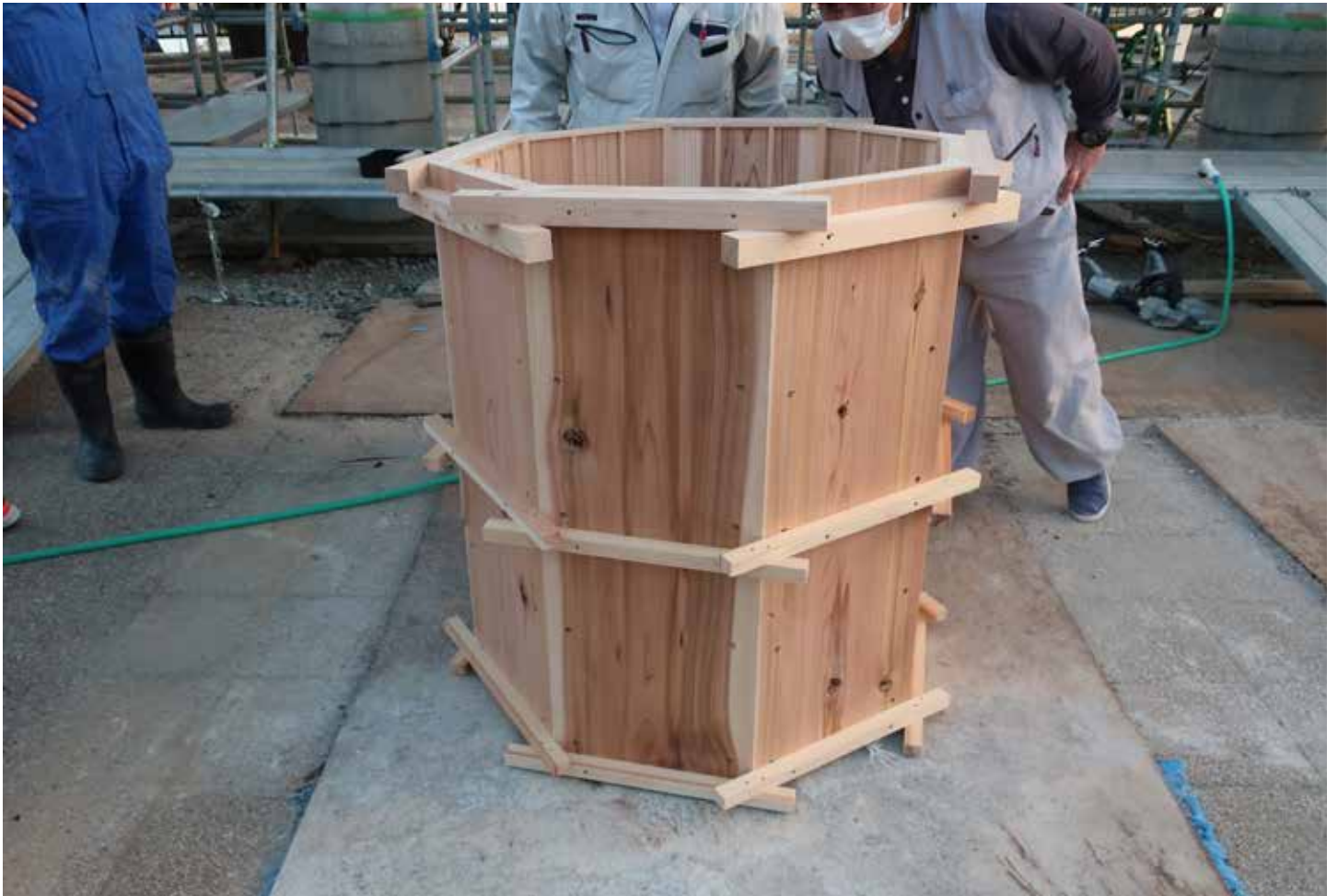
使用する型枠は、秋田杉製 本実加工された型枠
