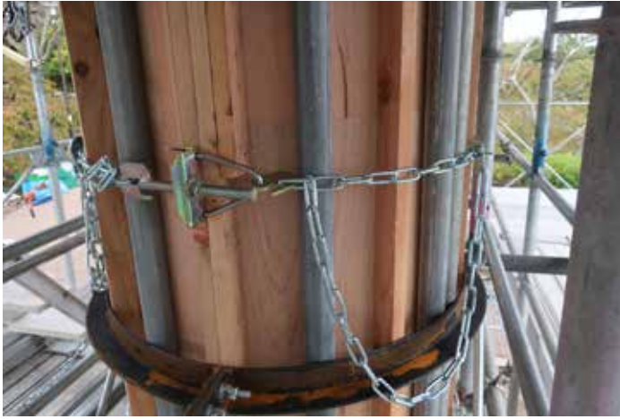
型枠工事：主柱 貫木 型枠固め (2021.10.7)
