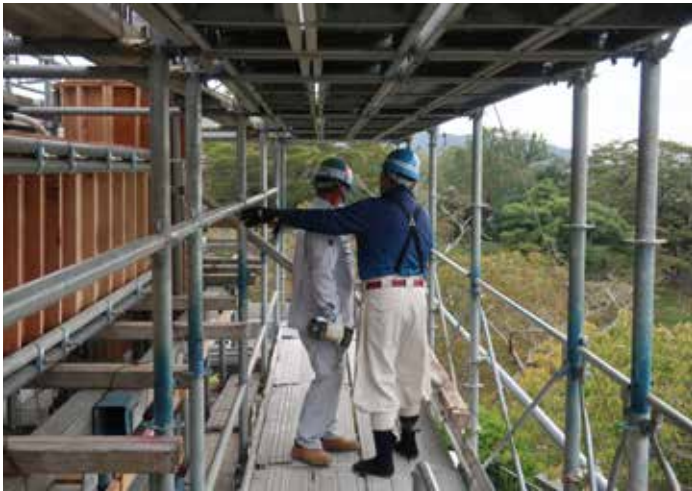
コンクリート打設前に支柱型枠の斜傾しないようにワイヤーの取り方を指導する遠藤会長
