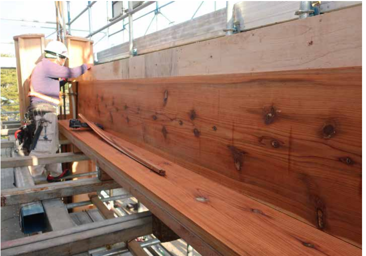
主柱貫木部型枠建込
