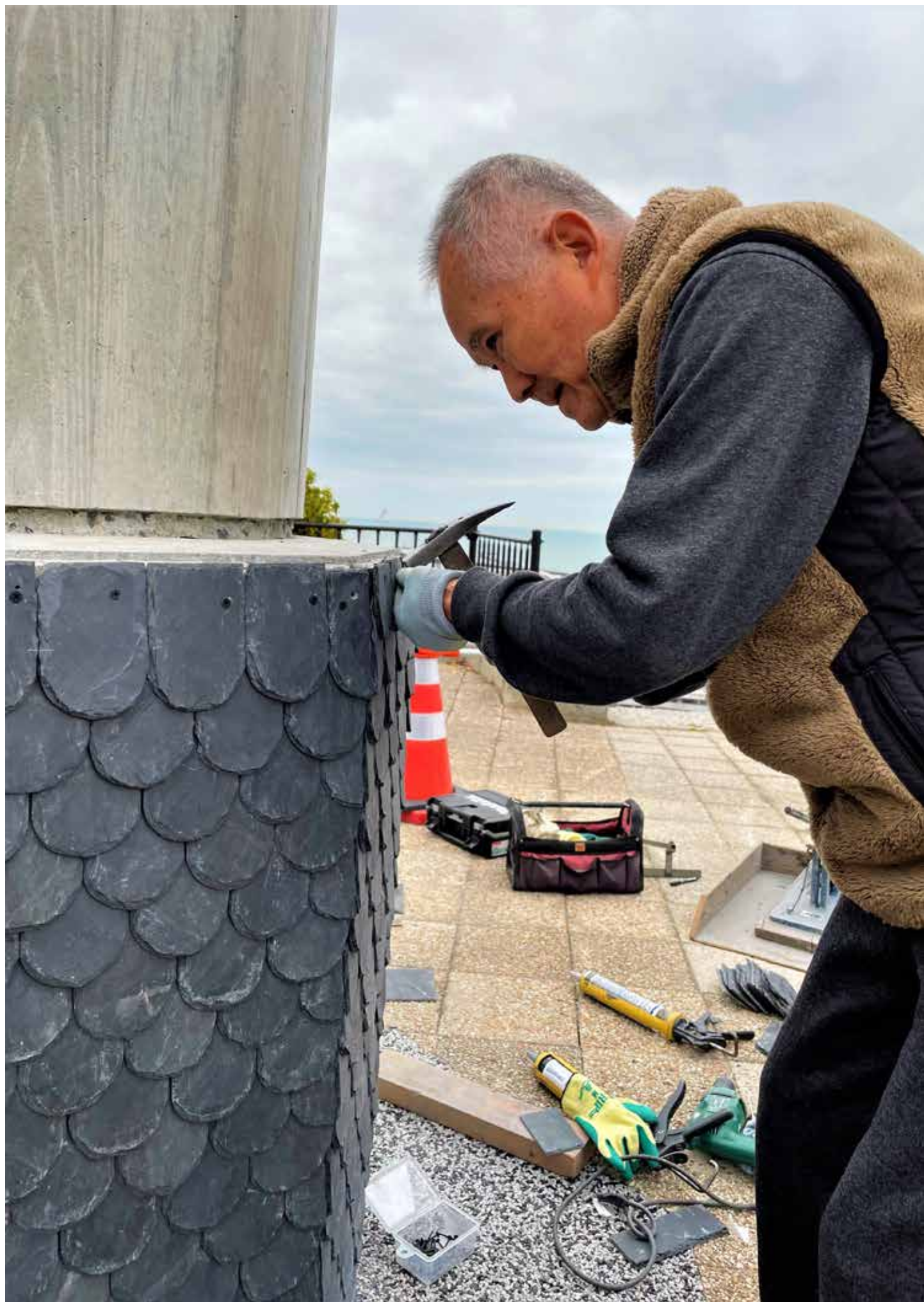
令和の大改修を奉納記念として、天端雄勝スレートを加工する 49代 窪木兼忠 元宮司
