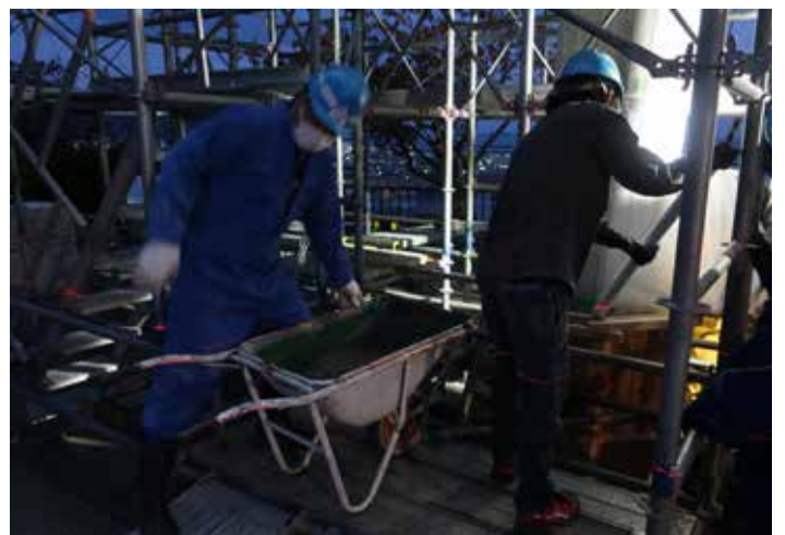
人力でコンクリート運搬・打設
