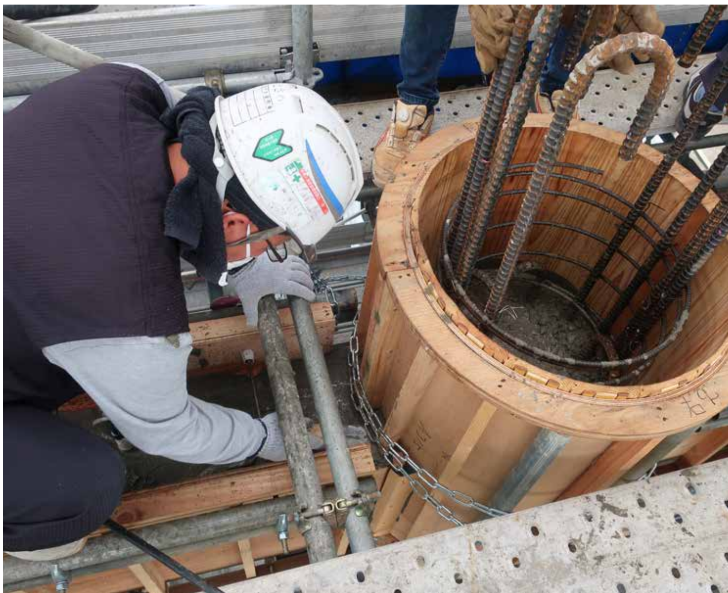
コンクリートは高さ 1.5 m 毎に 3 回に分け打設
