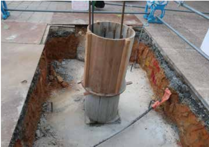
主柱基礎部コンクリート打設
