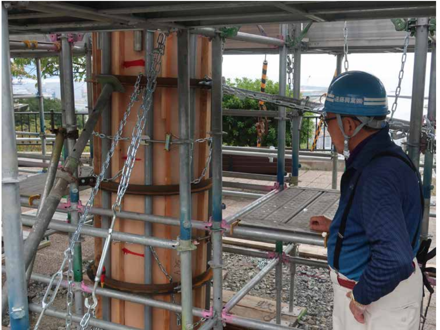
コンクリート打設完了後、型枠の膨張変化及び傾きを確認する遠藤会長
