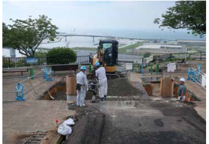
1層目埋戻状況 埋戻材 C-40
