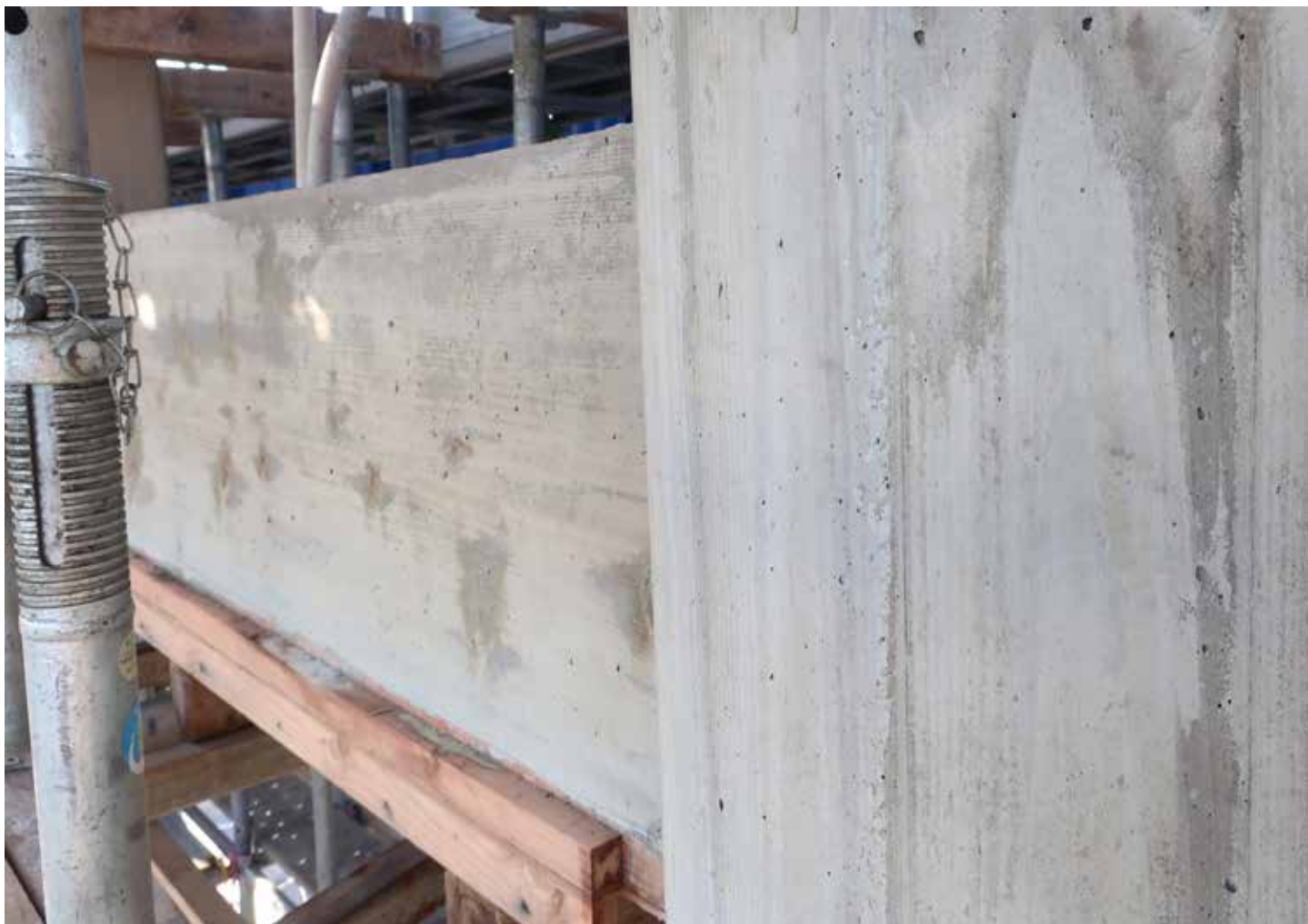
鳥居の柱と貫木の接合部
