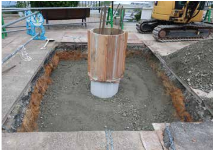
1層目締固め完了状況
