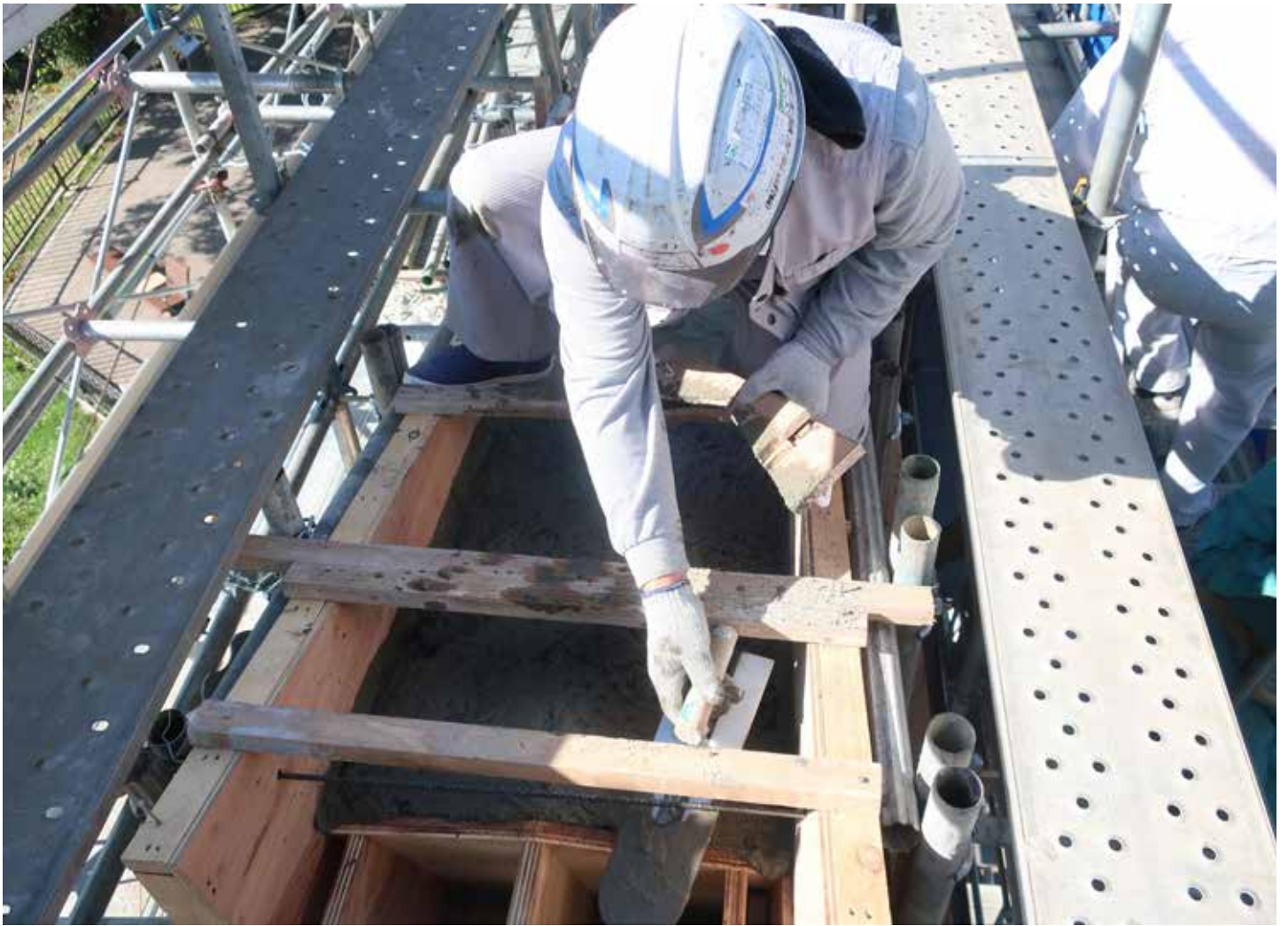
鳥居の最上部にあたる笠木は、中心から両端に向けて天を仰ぐように反り増しがあり、幅も両端に向けて太くなる形状。 笠木は山型形状であるため、仕上げ左官には熟練の技がいる。
