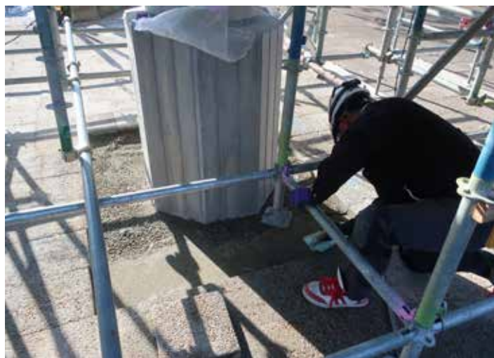
基礎周辺の平板ブロックを基礎形状と同じように八角形に仕上げる
