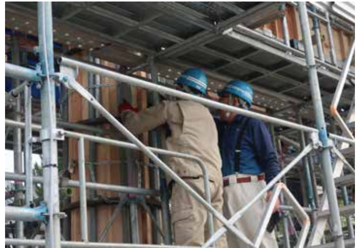
コンクリート打設前に支柱型枠の斜傾しないようにワイヤーの取り方を指導する遠藤会長
