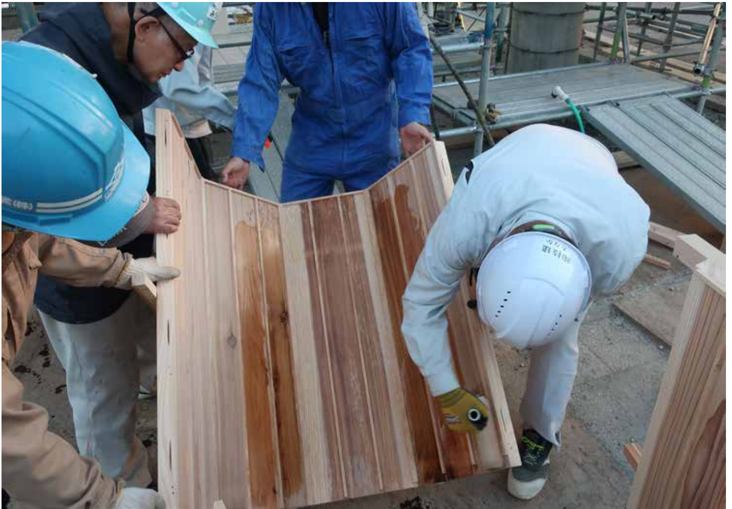
秋田杉で製作された亀腹部の型枠
