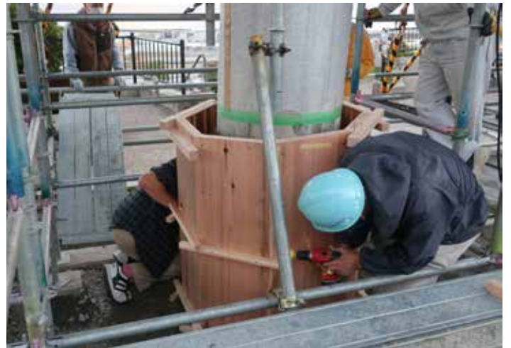
秋田杉で製作された亀腹部の型枠
