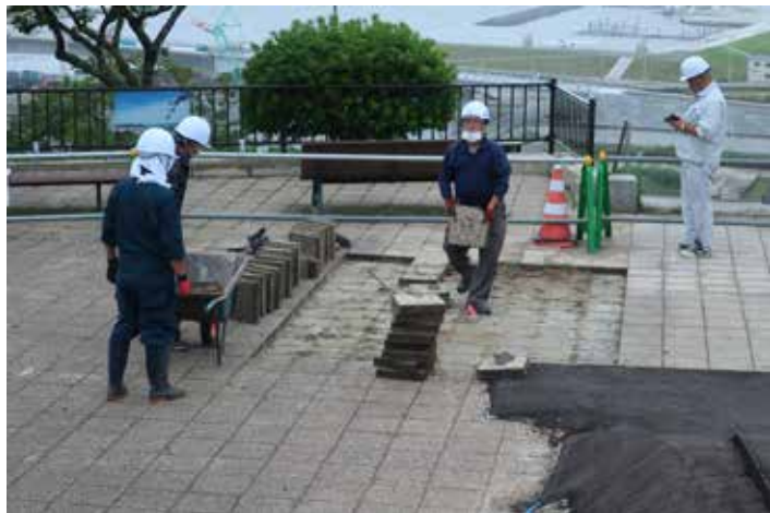
既設平板ブロック撤去
