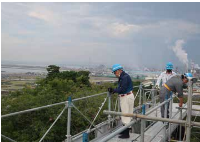
コンクリート打設前に支柱型枠の斜傾しないようにワイヤーの取り方を指導する遠藤会長
