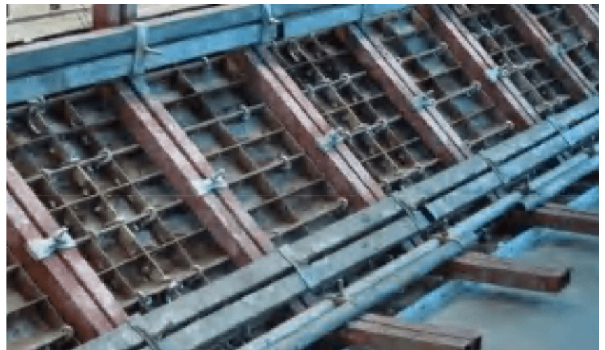
写真-1 押え金具使用状況（出所 岡谷建材カタログ）
