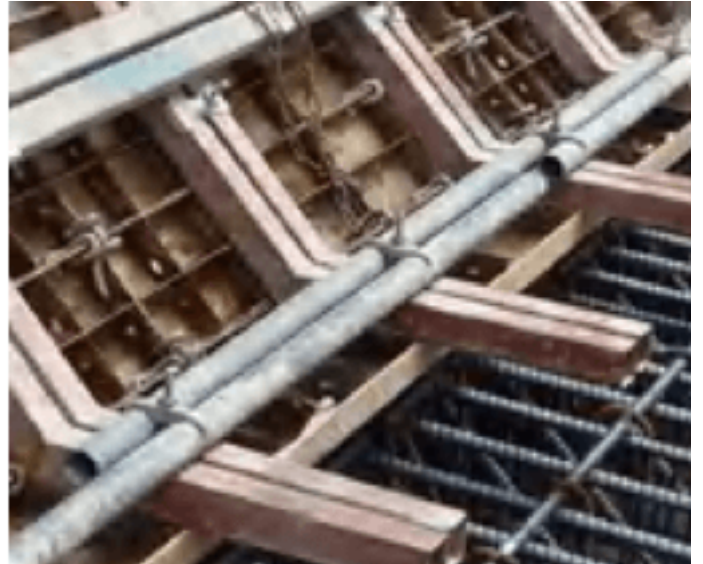
写真-2 浮き型枠 (出所 岡谷建材カタログ)
